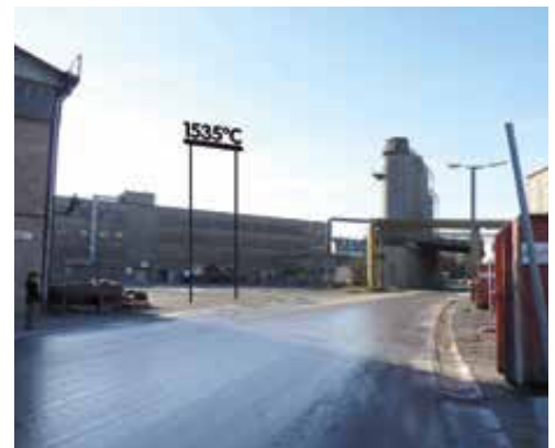
1535°, Schaffungsstätte für die Kreativindustrie, Differdingen
