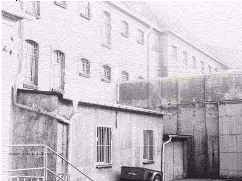
Geschlossener Jugendwerkhof Torgau: Schleusenbereich. Quelle: DIZ Torgau
